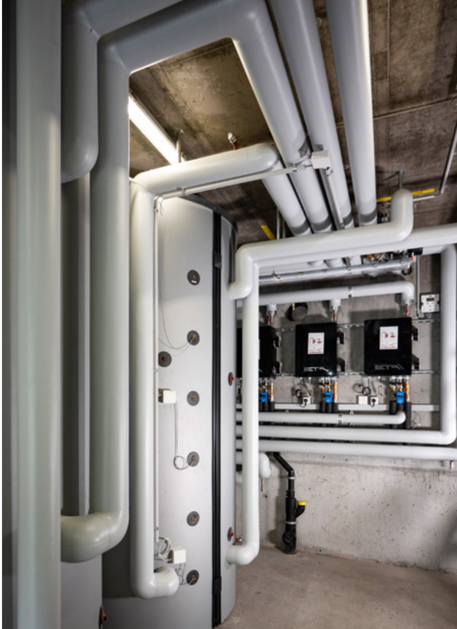
Zwei grosse Speicher mit Frischwassermodule für die Warmwasseraufbereitung des Sanitärbereichs.
