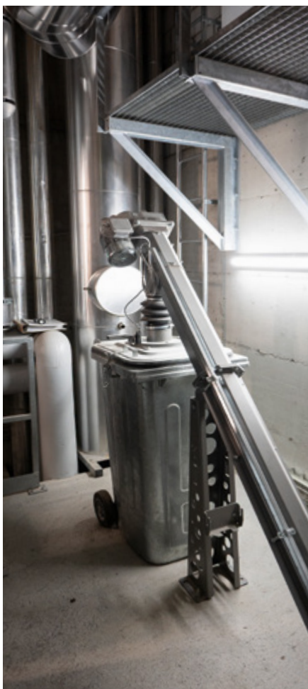
90% weniger Feinstaubausstoss dank elektrostatischem Partikelabscheider.
