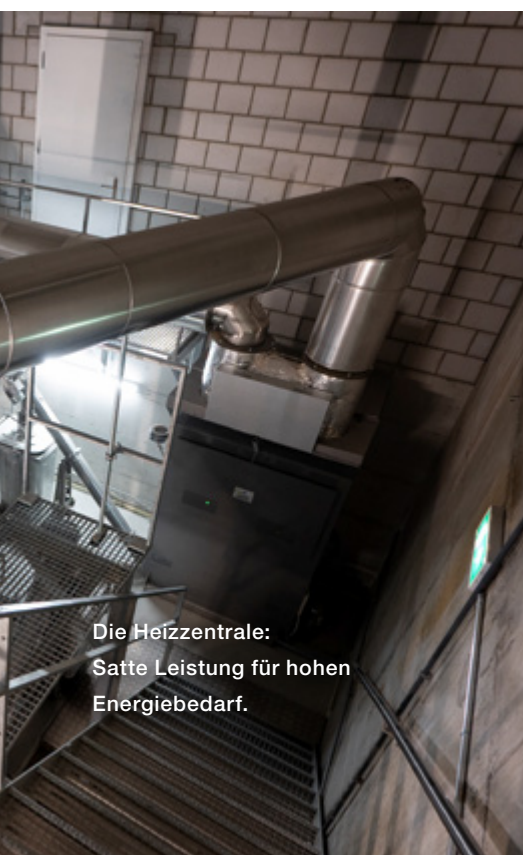
90% weniger Feinstaubausstoss dank elektrostatischem Partikelabscheider.
