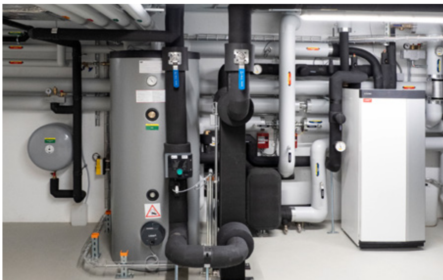
Die besten Jahresarbeitszahlen erreichen Wasser/Wasser-Wärmepumpen.
