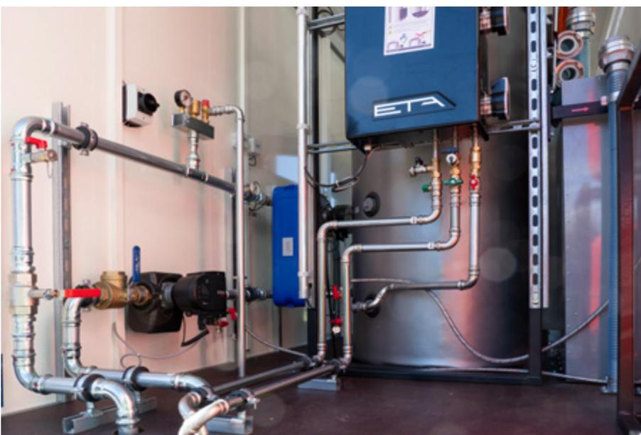
Links die mit einem Wärmetauscher getrennte Heizgruppe und rechts im Bild das Frischwassermodule für die Warmwasseraufbereitung.
