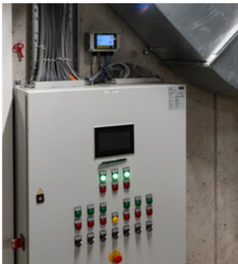
Schaltschrank für die Steuerung der Brennstoffauftragung
