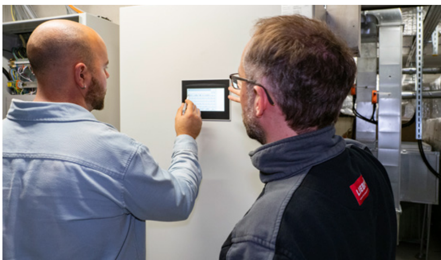
Schulung der Haustechniker vor Ort.
