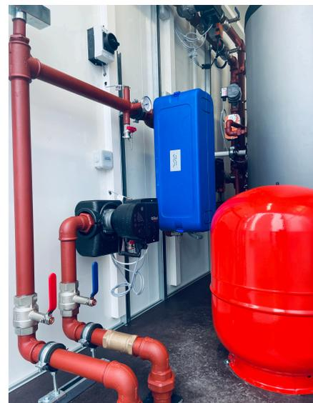
Trennung des Primär- und Sekundärkreislaufs. 1 33 533 83 83
